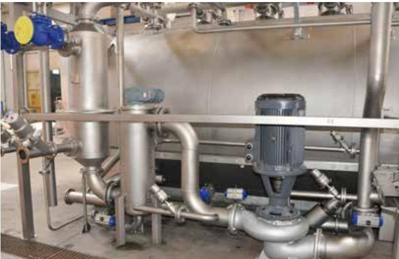
Ana pompa, Otomatik filtre, Eşanjör tesisatı / Main pump, Automatic filter, Heat exchanger installation
