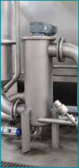
Otomatik filtre Auto filter
