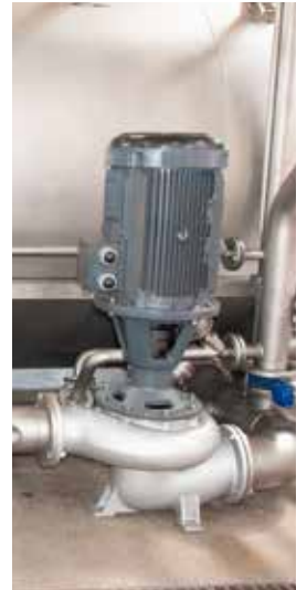
Ana sirkülasyon pompası main circulation pump
